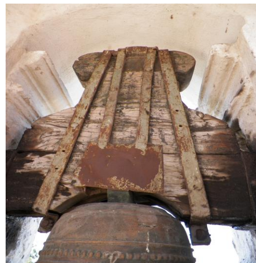
Instalación del yugo de madera.
