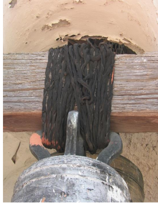
Instalación de la campana a la usanza tradicional.
