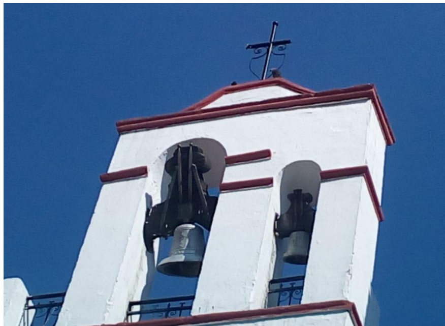
Vista poniente de la espadaña.
