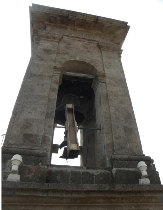
Torre campanario vista desde el norte.
