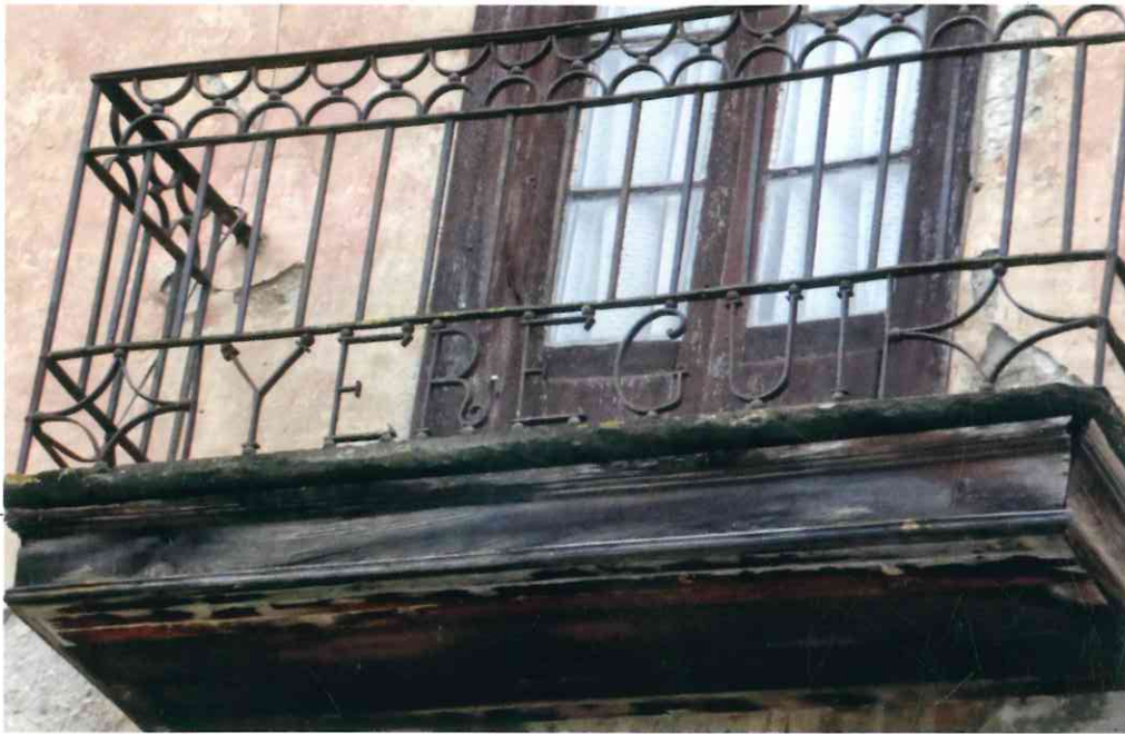
Fig. 9 Balcón de la casa de los Yeregui en Betelu.
