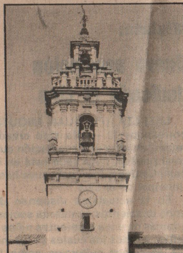
Con el paso del tiempo, se han ido desprendiendo materiales y se ha inclinado ligeramente la torre. (Foto, J. Martínez.)
