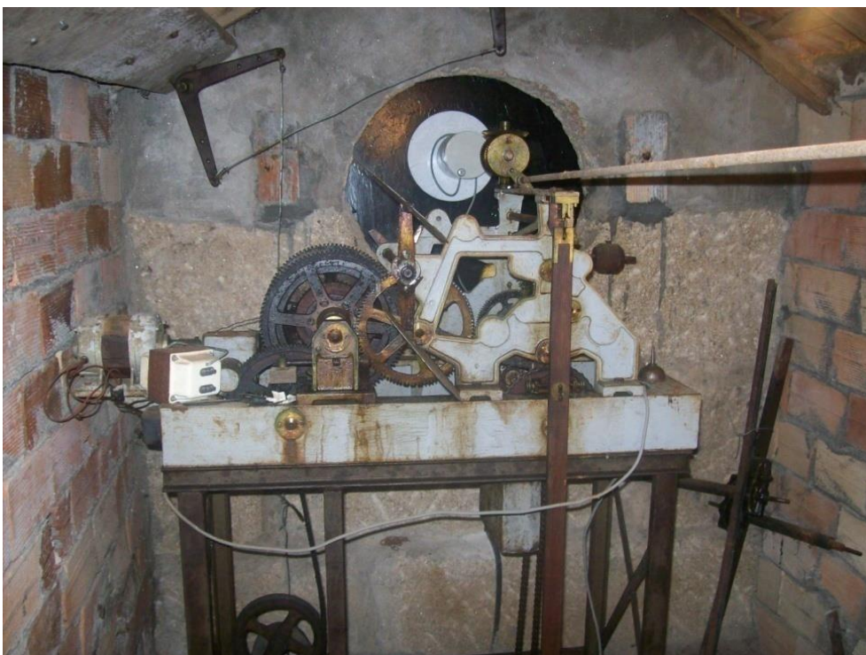
(FOTO 14) Vista frontal da maquinaria do reloxo da E. L. M. de Queimadelos.
