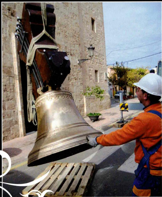
Foto: Carpesa - Valencia Restauración Campanas
