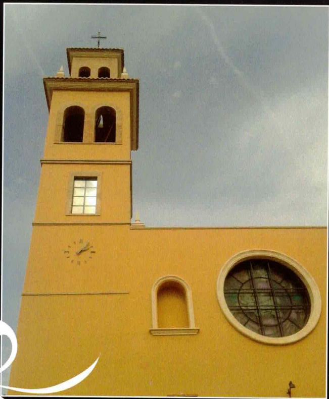
Foto: Moncada - Valencia San José - Restauración Campanas, reloj e instalación pararrayos
