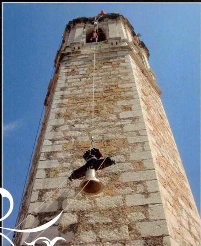
Foto: Cervera del Maestre - Castellón Restauración Campanas y Campana Nueva
