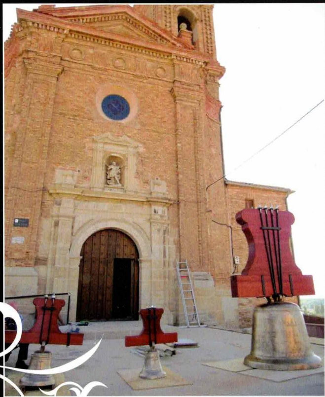
Foto: San Adrián - Navarra Restauración Campanas
