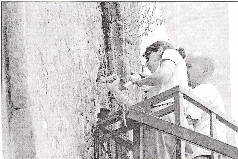
Una restauradora, en las labores de cata en la fachada de Santa Catalina.
