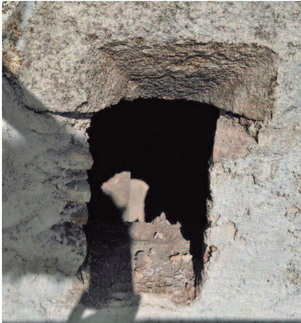
La tronera del campanar ocupa una posició més baixa i servia per disparar amb arcabús
