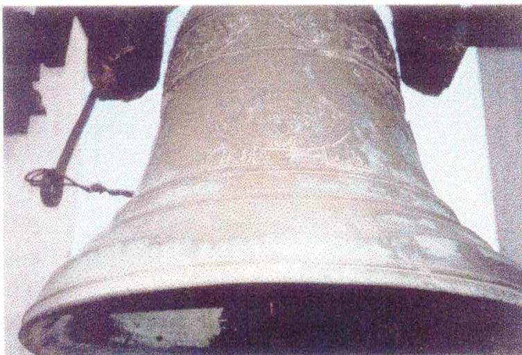
El badajo se encuentra en un avanzado estado de oxidación, no disponiendo de ningún elemento de seguridad que impida su posible desprendimiento en caso de rotura.
