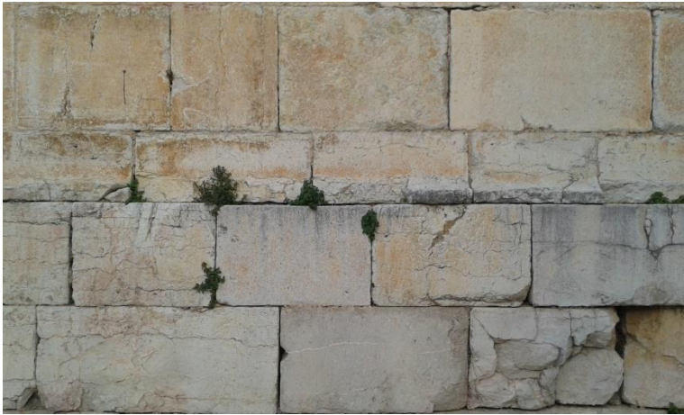
15. Estado actual fachada
