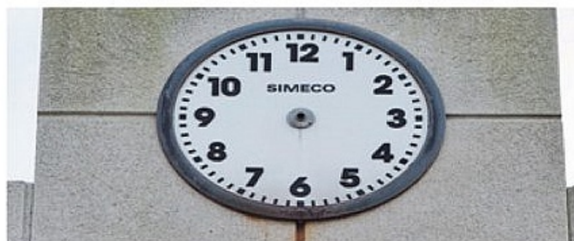
MALPICA. Sin agujas, la reparación costará 1.600 euros.
