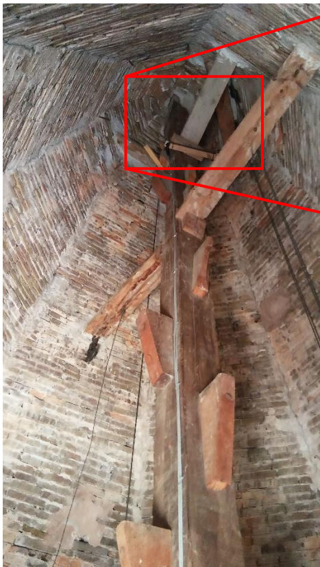
Es necesaria la supervisión exhaustiva del sistema de poleas y contrapesas del reloj, y su reparación si procede.
