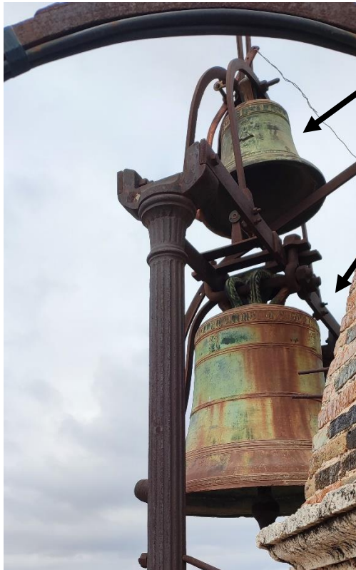
Ballesta averiada, no eleva el martillo.
