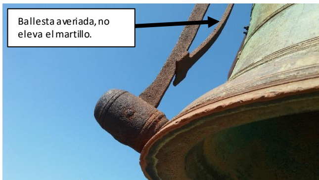
Ballesta averiada, no eleva el martillo. Salida de los cables del toque mecánico
