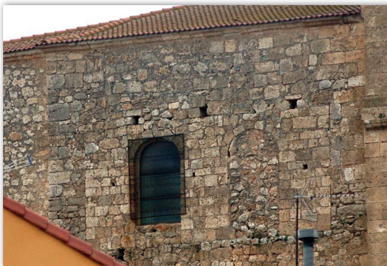
Fig. 4.- Nava de Roa. Muro occidental de la nave, donde se aprecian los huecos de la espadaña embutidos en el recrecido del muro.
