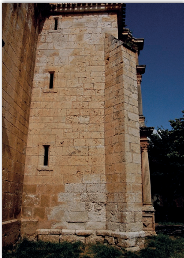
Fig. 10.- Muro donde se solapa la obra del cuerpo de la iglesia de Sotillo (derecha, finales del XVII) con el arranque del caracol de la torre (izquierda, Domingo de Ondátegui, 1735).
