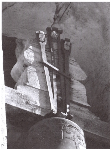
Detalle del yugo y herrajes de la campana de Dos Torres de Mercader. Foto de los autores.
