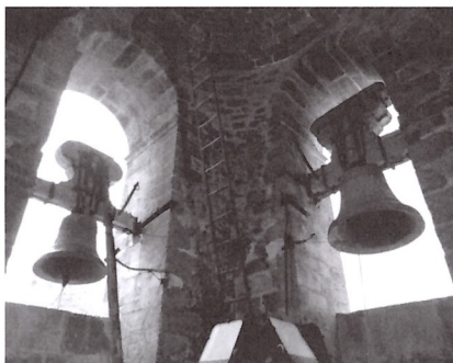
Sala de las Campanas del campanario de Mirambel. Foto de los autores.
