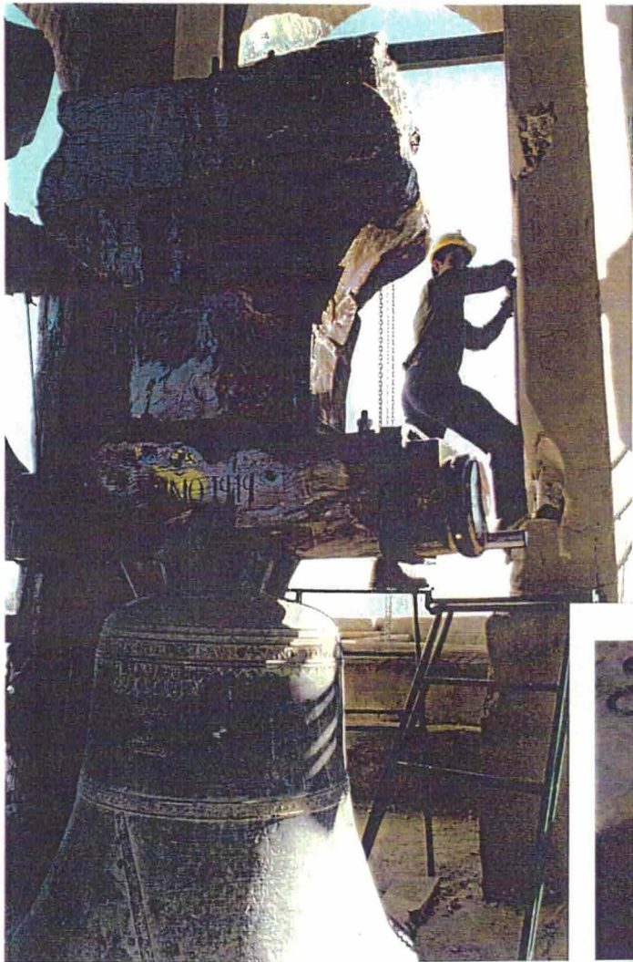
Montaje de los yugos restaurados a la derecha ,pieza de yugo en fase de restauracion
