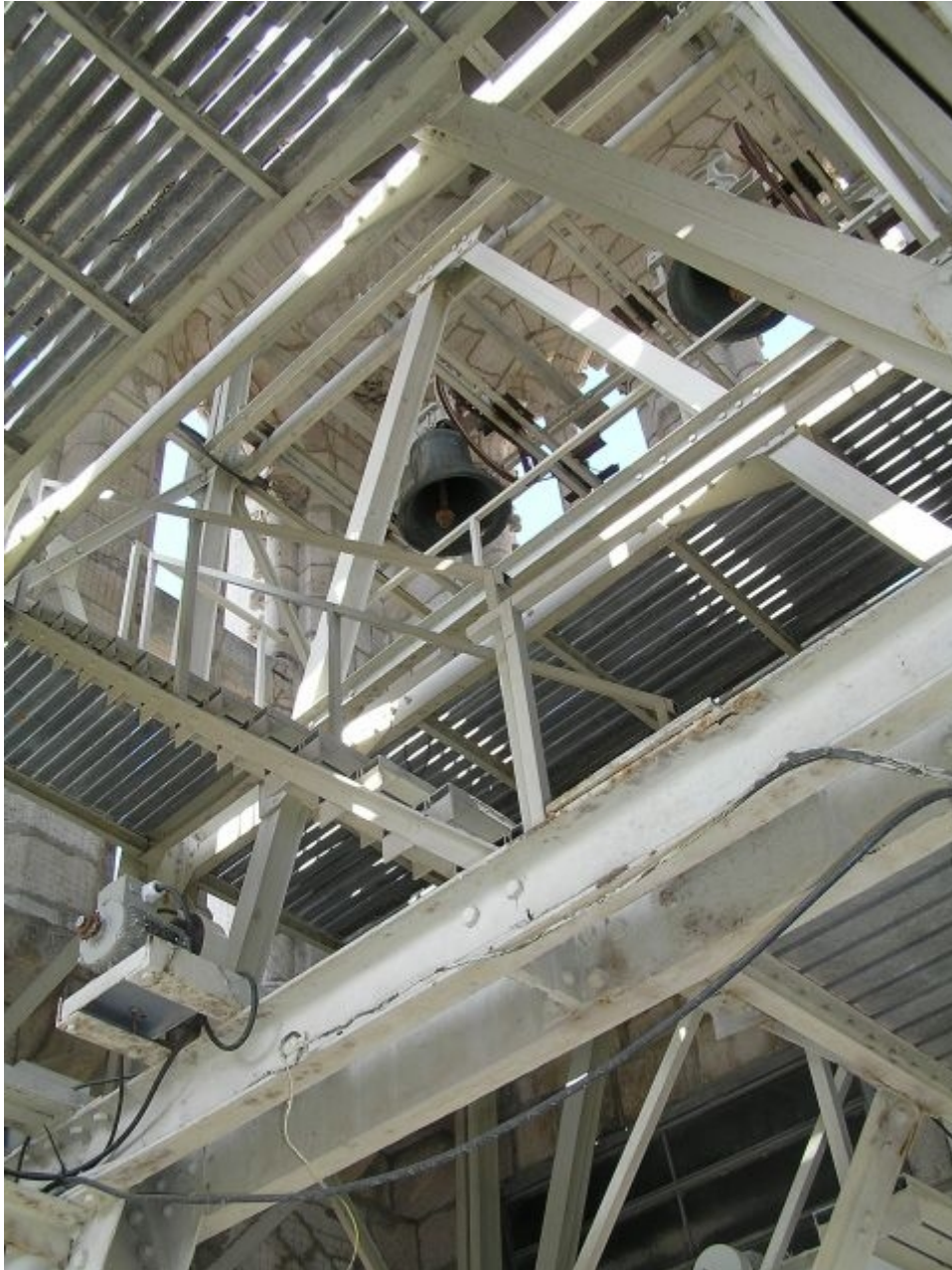
Estructura metálica interior de la torre este (16-09-2005)
