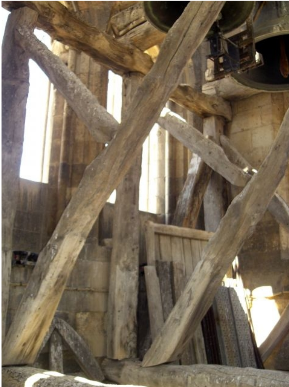
Interior de la sala de campanas (05-09-2006)
