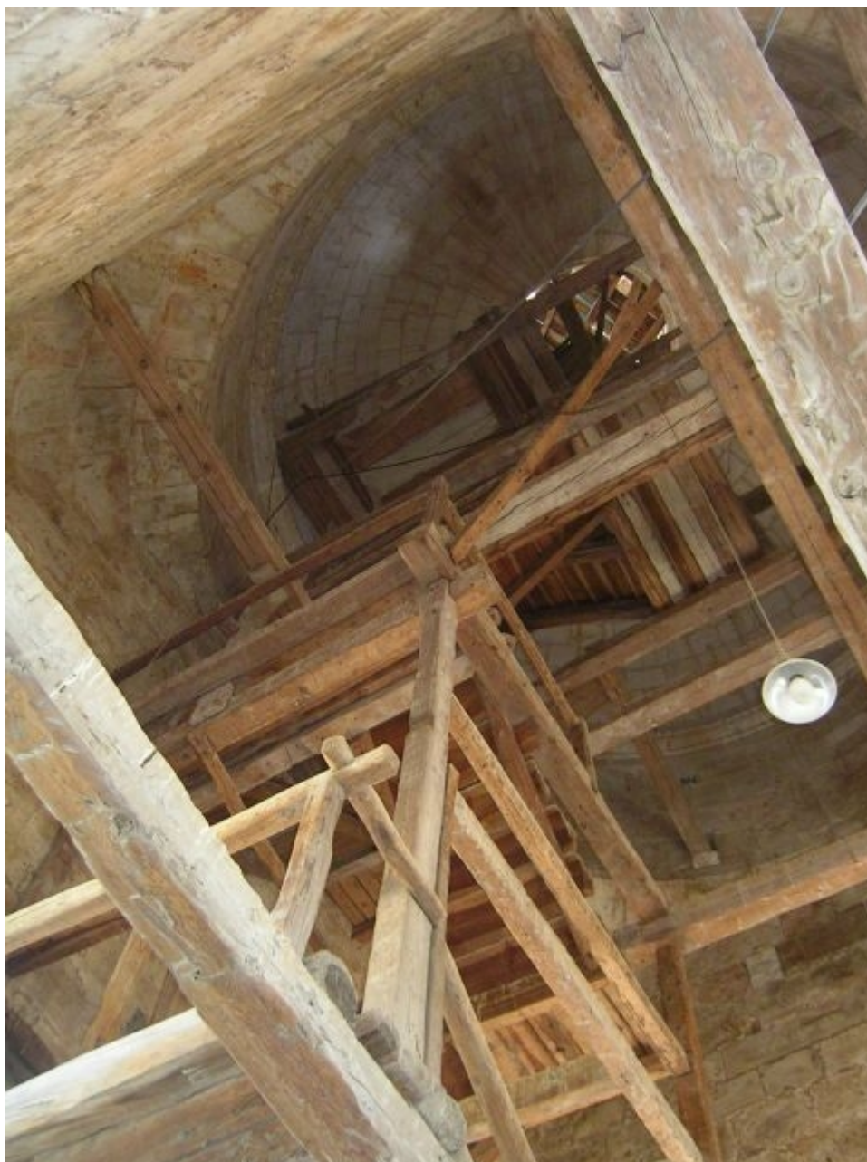
Estructura interior desaparecida en las reformas de 2008. (02-09-2005)
