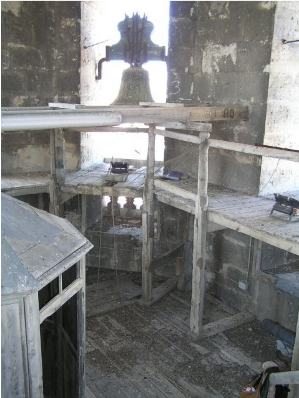
Estructura de tarimas para tocar manualmente las campanas (14-09-2005)
