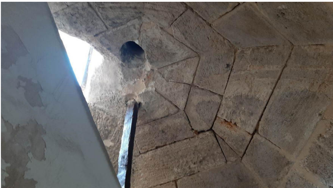
Fig. 2.A.3. Vista de la bóveda gallonada de cantería que cierra el fuste para formar la planta del cuerpo de campanas.
