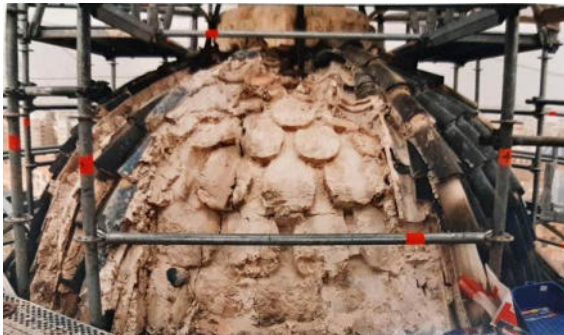
Proceso de desmontaje de la cobertura de teja vidriada bajo la que permanecía la cúpula de sillares tallados en forma de escamas y el estado final tras el proceso de restauración.
