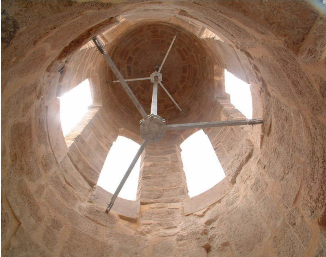
Fig. 2.A.7. Estructura interior de atirantamiento de la cúpula y sujeción de la veleta.
