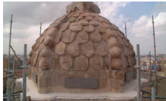
Proceso de desmontaje de la cobertura de teja vidriada bajo la que permanecía la cúpula de sillares tallados en forma de escamas y el estado final tras el proceso de restauración.
