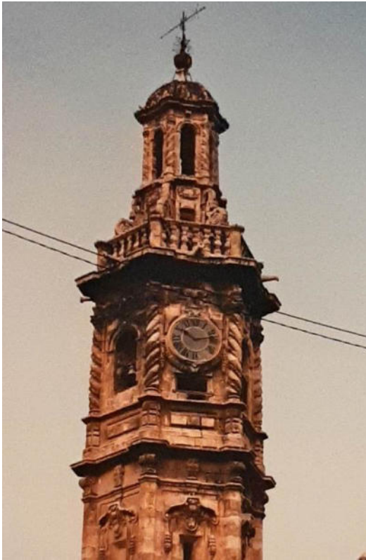
Alzado este de la torre campanario antes y después de la intervención de 2001 en el que se eliminó el reloj urbano y la cobertura de teja vidriada azul y blanca.
