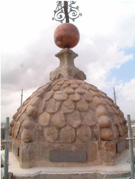
Fig. 2.A.8. Veleta y pletinas exteriores de atirantamiento de la cupulín.
