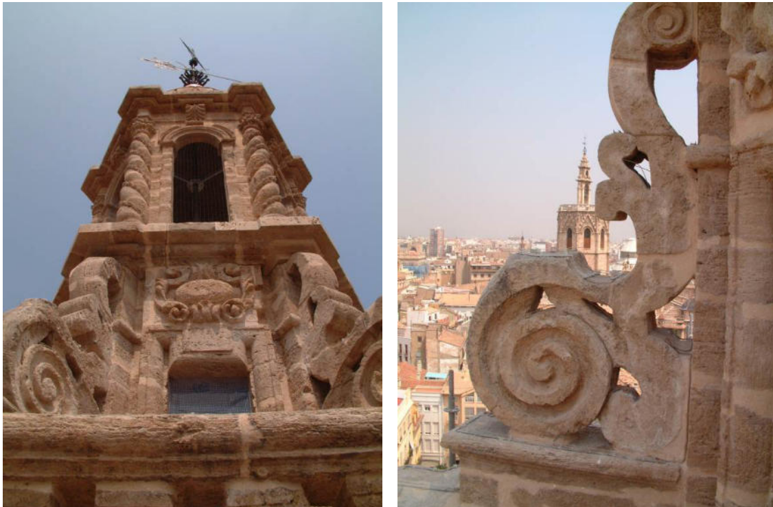
Fig. 2.A.6. Templete de remate del campanario de Santa Catalina e imagen de una de las seis volutas de las esquinas
