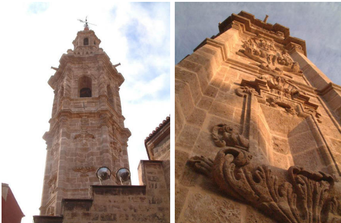
Fig. 2.A.1. Detalles de la fábrica exterior de sillería tallada del fuste del campanario.
