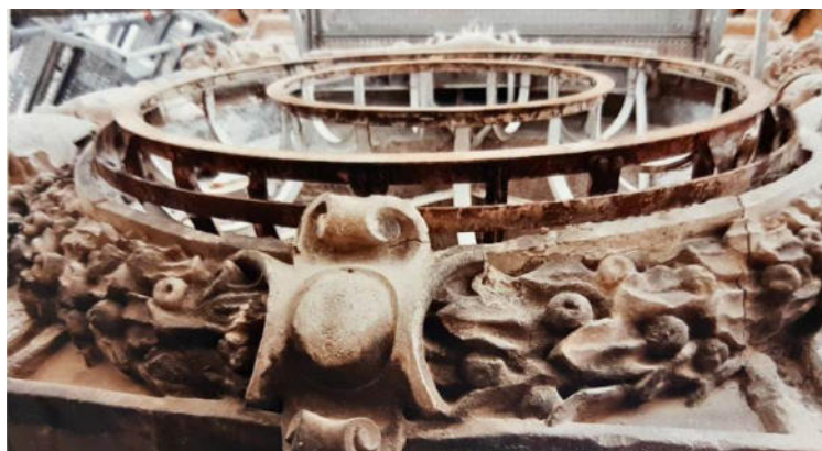
Proceso de desmontaje del reloj para la recuperación del hueco este de la campana mayor.
