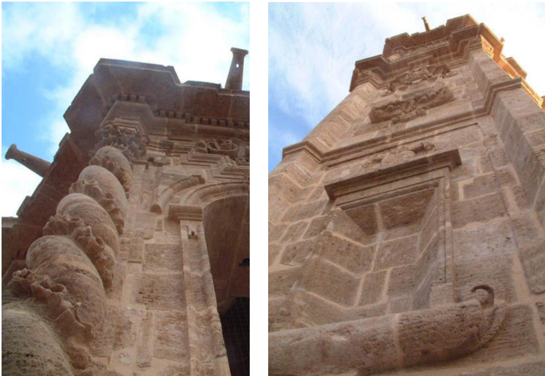
Fig. 2.A.9. Columnas salomónicas en las esquinas del nivel del cuerpo de campanas y ornamentación de los ventales en cada cara incluso los que no están conectados con el interior.
