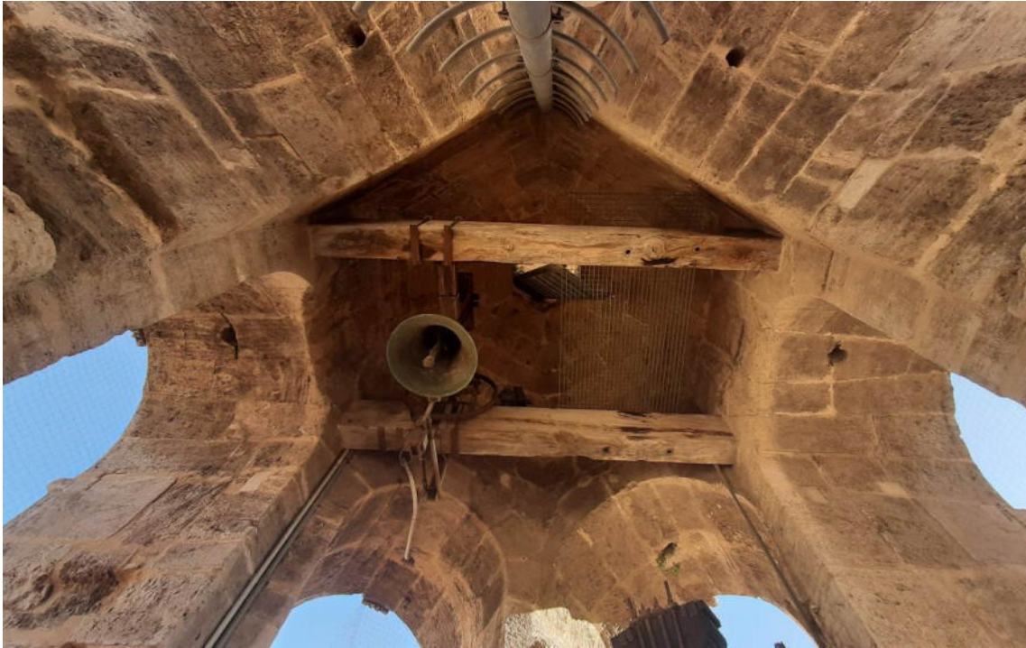
Fig. 2.A.4. Bóveda gallonada también de cierre superior del cuerpo de campanas.
