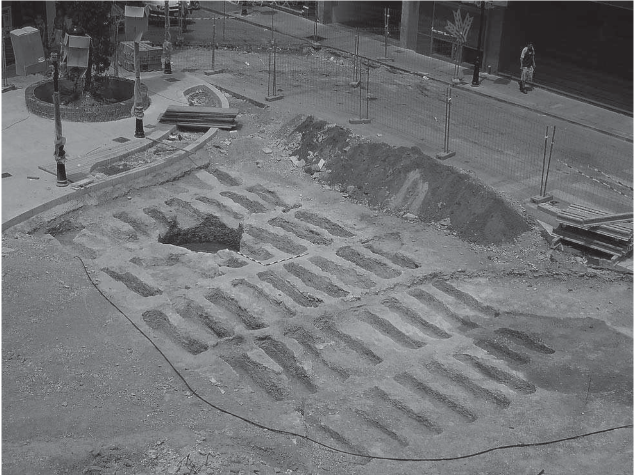
Figura 20. Vista general del área de intervención, una vez finalizada la excavación
