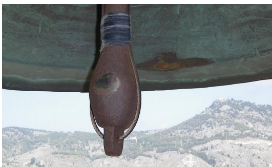
Detall del batall, el cordo de seguret i desgaste de la campana
