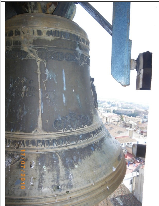
Detalls de la campana; cordons , epigrafía escudos, imatges, electromartell i eix (rodament)
