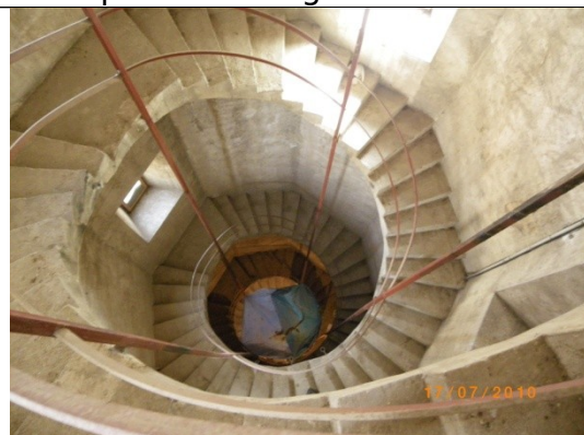
Plastic per a evitar la caiguda de pols a la part de baix del campanar
