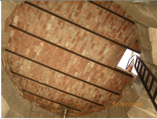
Teulada de la sala de campanes
