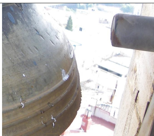
Detall del electromartell, pega en el seu punt. Hi ha restos de pintura de la truja de ferro en la campana.
