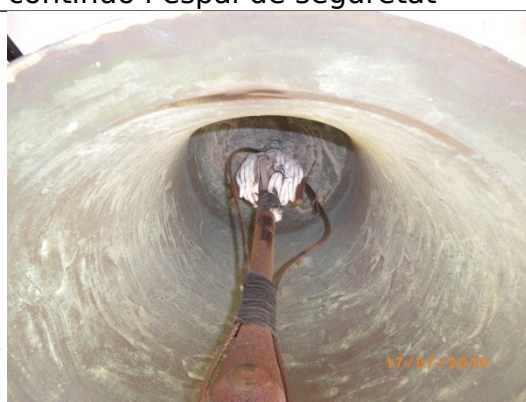
Batall de la campana i cable de seguretat
