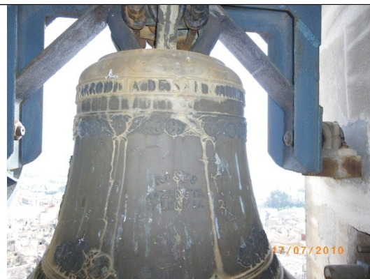
Oxidació de la campana i vista d'uno dels rodament
