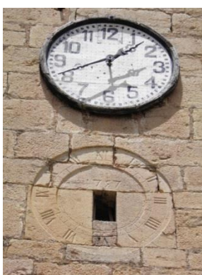
Esfera superior de xapa metàl·lica amb cercol de fusta i numeració àrabiga. La inferior incisa en la pedra: numeració romana per a les hores i àrabiga en la data 73
