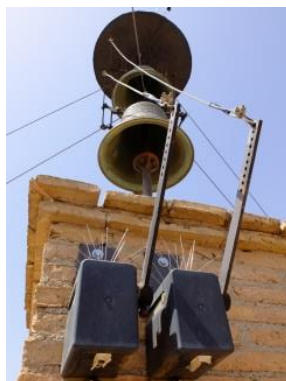
Motors de tir que alcen els malls de les campanes d'hores i quarts70
