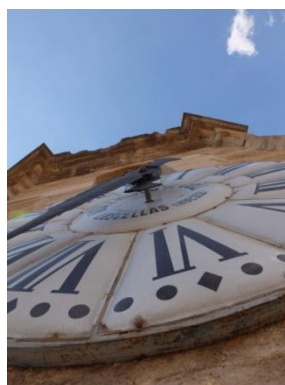
Esfera de chapa metálica esmaltada y numeración romana 74
