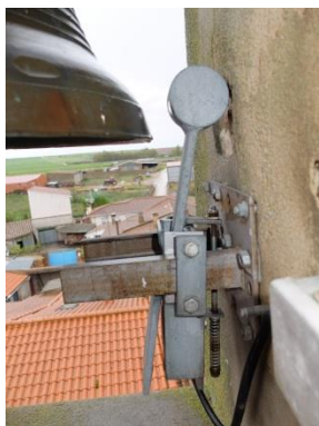
Electromazo fijado a la ventana (posición: 03) 68
