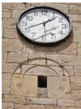
Esfera superior de chapa metálica con cerco de madera y numeración arábica. La inferior incisa en la piedra: numeración romana para las horas y arábica en la fecha 72
