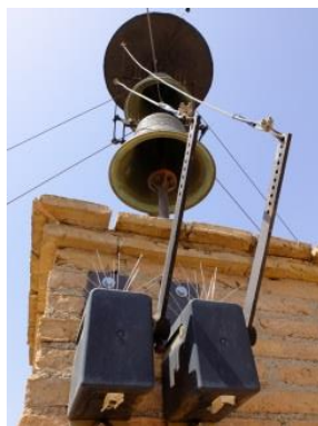
Motores de tiro que alzan los mazos de las campanas de horas y cuartos 69
