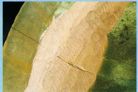
Durch rechtzeitiges Aufschweißen der ausgeschlagenen Schlagringstellen kann größerem Schaden (Riß) vorgebeugt werden.
