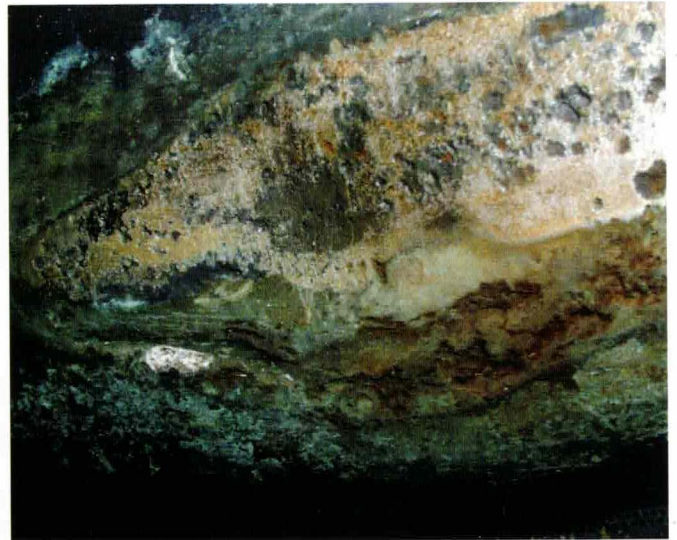
9 Materialzertrümmerung am Anschlag
