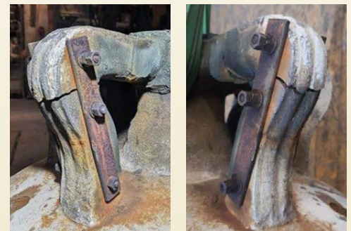
Refuerzo de un asa con pletinas de acero
