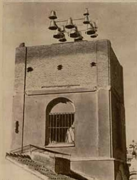
La torrecilla del ministerio de Hacienda, donde ha sido instalado el carrillón.
