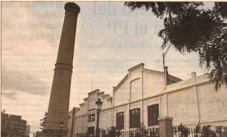
La subestación eléctrica de Patraix. / EL MUNDO
