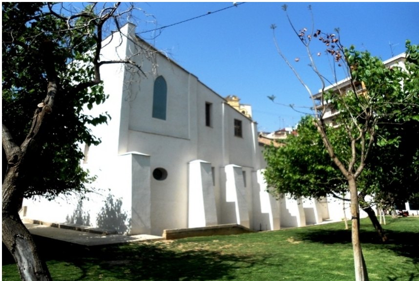
Vista de la fachada lateral izquierda (los contrafuertes que se observan fueron obra de su restauración). Foto: M a del Mar Calvo Lambro, 23-3-2012
