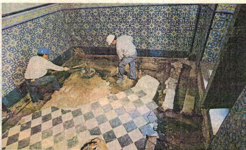
Catas y recalzamiento de los cimientos de Santa Lucía para reforzar la fachada. :: IRENE MARSILLA
