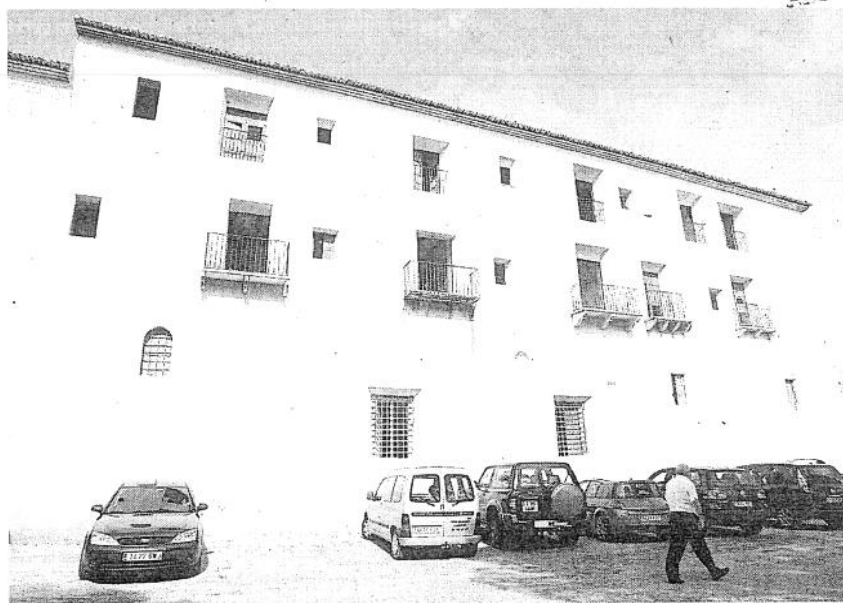
EDIFICIO. El nuevo hotel-escuela se hará en la zona donde está el Monasterio del Corpus Cristi. / LP
