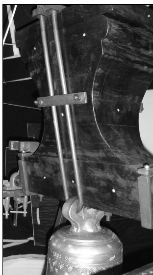
Fig. 1.2 – Fotografía de la geometría del asa y el yugo de la campana.
