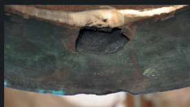
Detalls de les esquerdes i escrostaments del peu de la Carme, que van obligar a substituir-la. Foto: Josep Maria Caralt.
