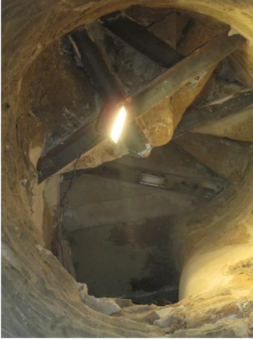
Detall estintolament primera tramada.
