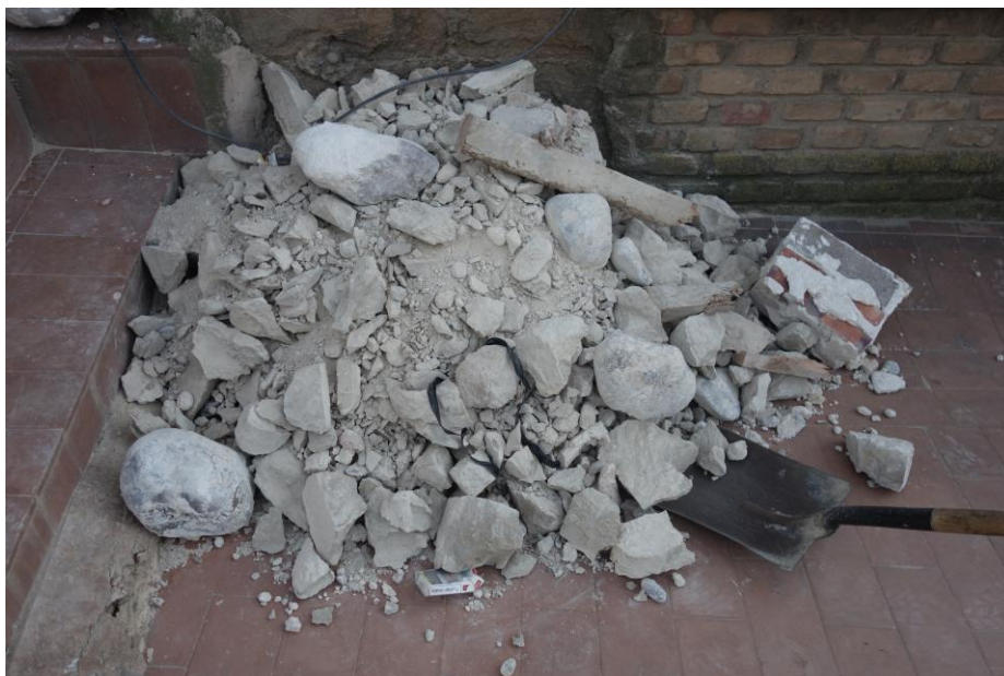
Reblert de l'arrancada de la segona tramada superior d'escales.
