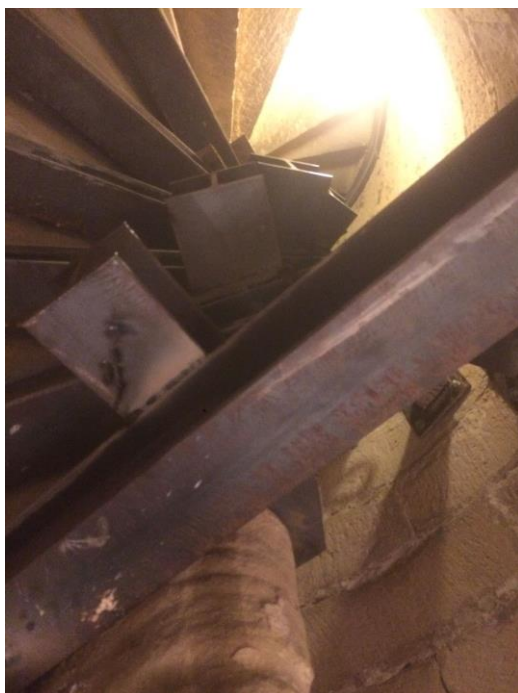
Detall de l'estintolament part superior campanar
