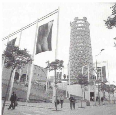
Ilustración 4: Vista general del pabellón.
