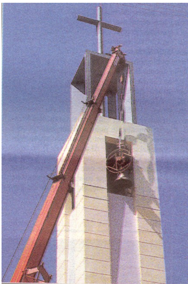
Momento de la colocación de las campanas.
