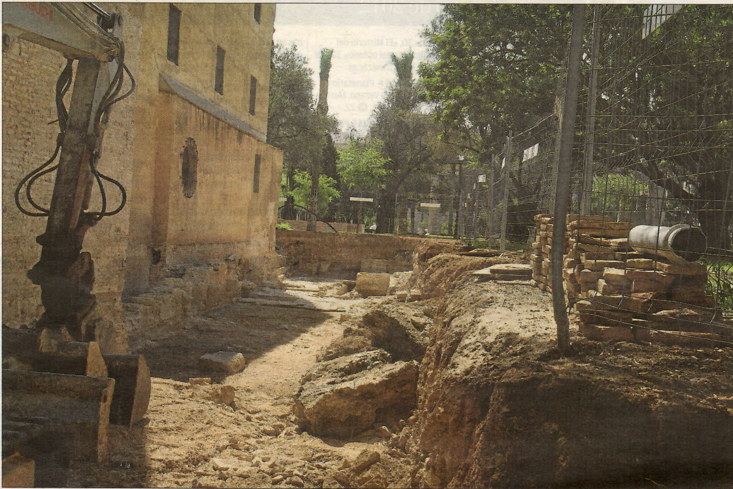
Terraplén excavado en el jardín del Muvim para liberar la fachada oeste de Santa Lucía. VICENT M. PASTOR
