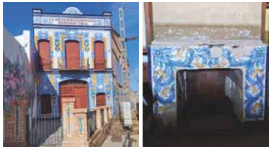
Fachada principal, estancia de la vivienda destinada a salón. Fuente propia.
