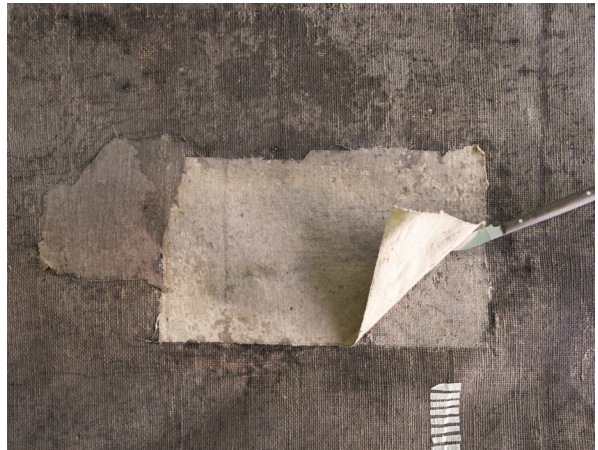
Fig. 26 - Eliminación mediante escalpelo
